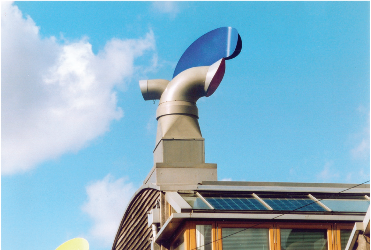
DE SPECIALE VENTILATIESCHOUWEN (WIND COWLS) VERZORGEN DE IN- EN OUTPUT VAN HET MOTORLOZE BALANSVENTILATIESYSTEEM IN DE ECOWIJK.
